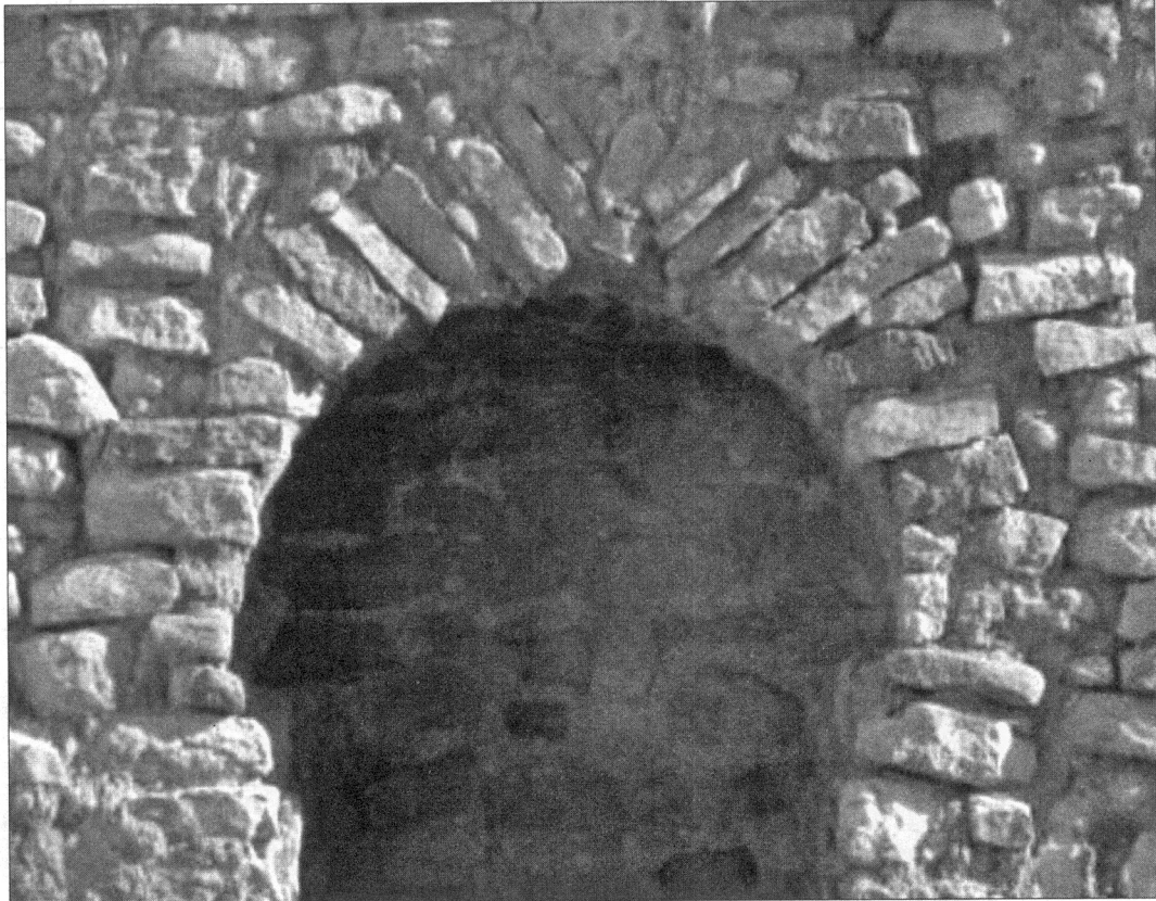
شکل ۶- کاخ اردشیر فیروز آباد: نمونه‌ای از پوشش تاق قوسی
